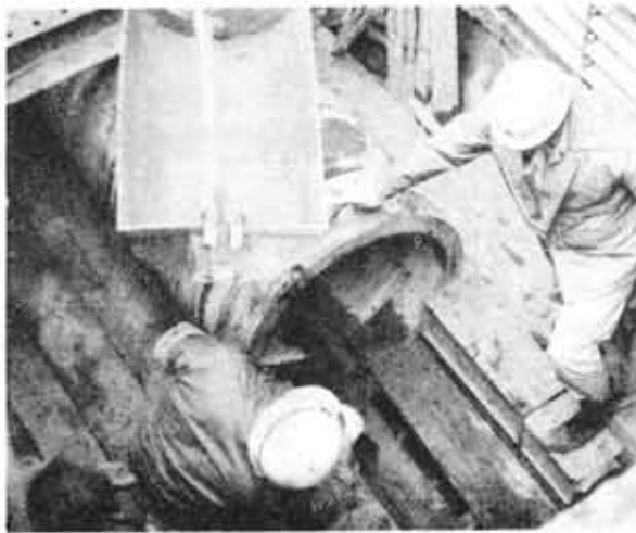
下水道管敷設工事(森本町天神ノ森)
