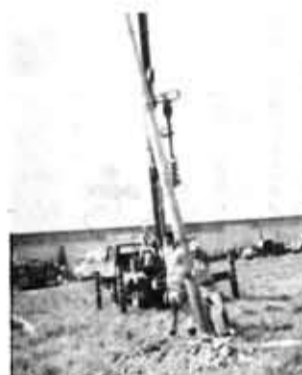
電柱の復旧作業
