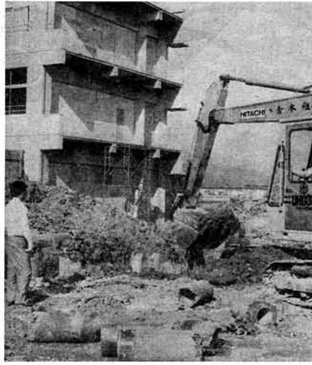
(増築工事を進める第四向陽小)
