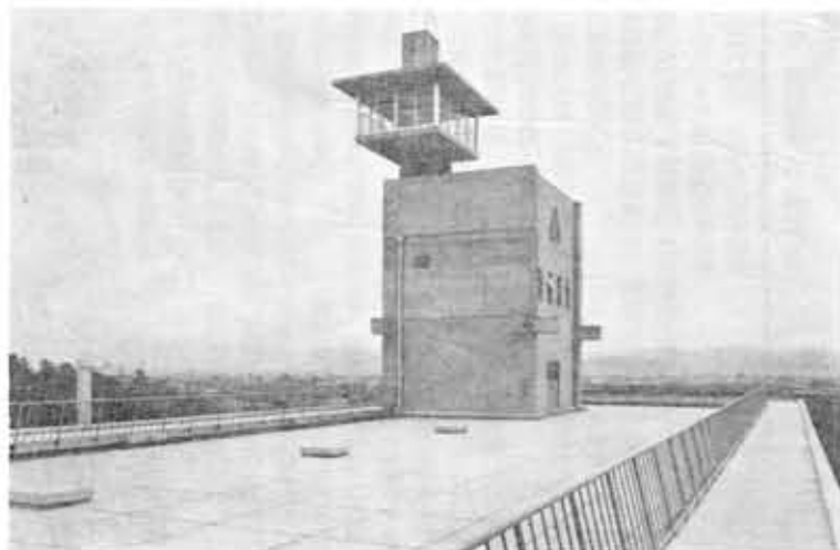
◀屋上から望楼を望む
