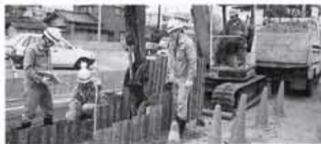
7年度完成に向け進む下水道工事
