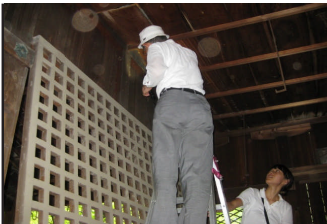
写真 1-4-5-1 向日神社境内社調査風景
