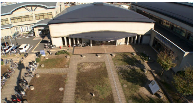
写真 1-2-5-4 市民温水プール
