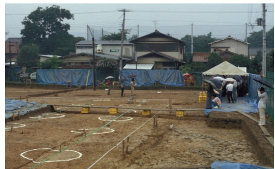
写真 2-2-2-7 礎石建物の検出状況
