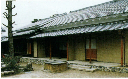
写真 2-3-3-3 須田家住宅裏庭からみた主屋西面
