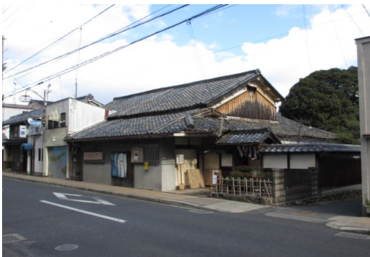
写真 2-3-3-5 富永屋店棟建物全景(南西から)
