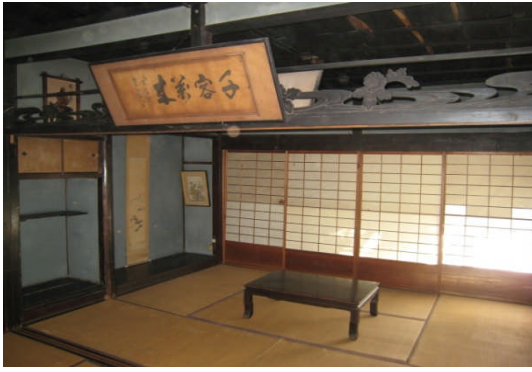
写真 2-3-3-6 富永屋座敷現況
