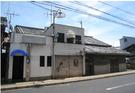
写真 3-1-3-1 現代風の増改築がされた町家
