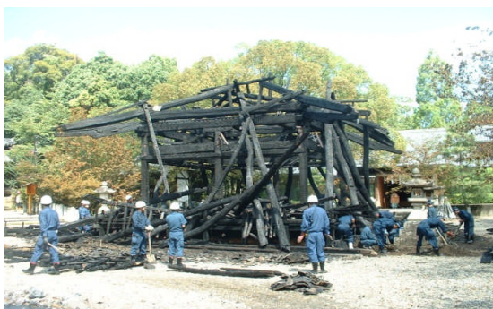
写真 5-5-1 文化財建造物の火災
