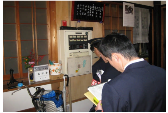
写真 5-5-4 消防立入検査
