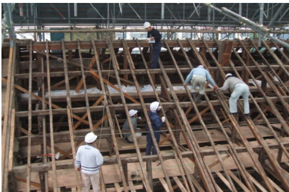
写真 5-2-1 文化財建造物の修理 (南真経寺)
