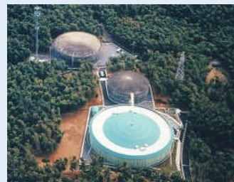
物集女配水池
