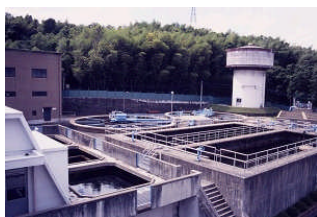
物集女西浄水場
