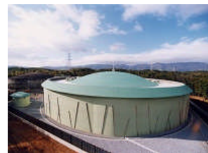
物集女新配水池（第1配水池）
