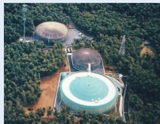
物集女配水池
