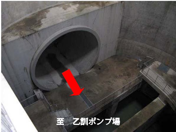
⑥乙訓ポンプ場到達部 至 乙訓ポンプ場
