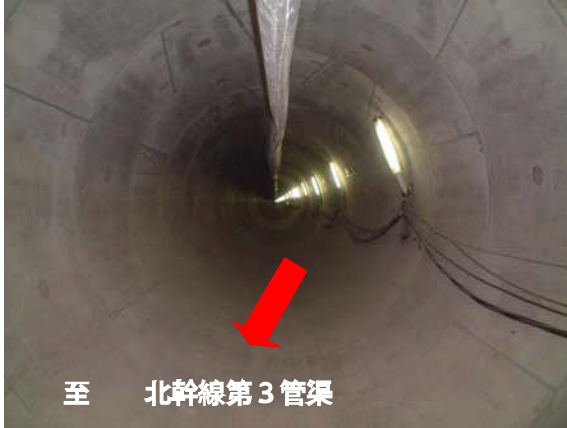
④雨水北幹線第2号管渠供用中(径3.0m) 至 北幹線第3号管渠
