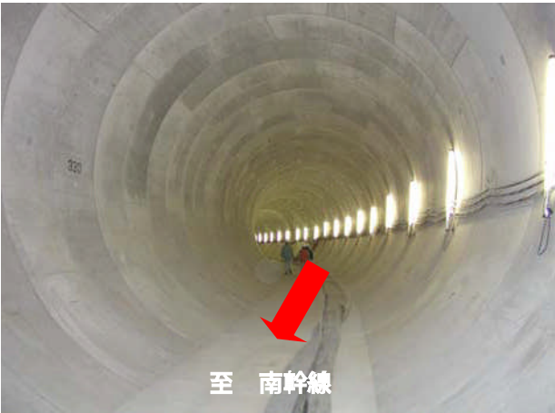
⑤雨水北幹線第3号管渠供用中(径6.1m) 至 南幹線
