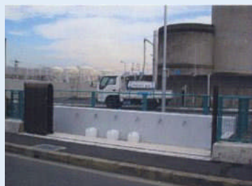
上植野浄水場の応急給水施設
