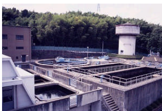
物集女西浄水場
