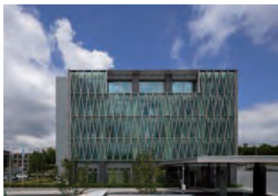
向日市役所本館
