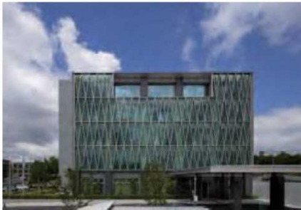
向日市役所本館
