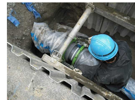
耐震管の接続
