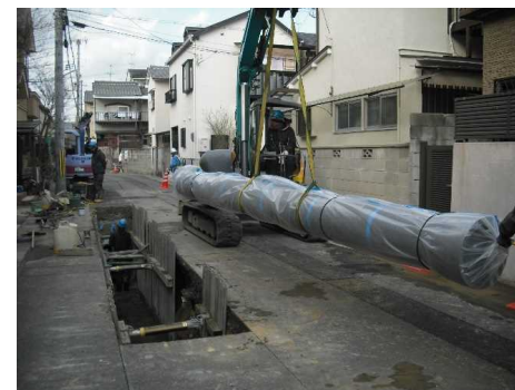
水道管路更新工事（耐震管の設置）
