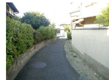
鶏冠井町御屋敷他地内 (市道第4017号線)
