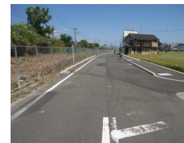
J R東海道本線東側 (上植野町堀ノ内地内) (市道第4047号線)
