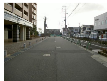
J R京都線深田川踏切東側 (市道第3031号線)
