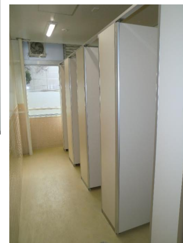
■トイレ改修後
