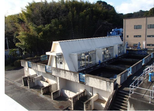
急速ろ過池(外観)
