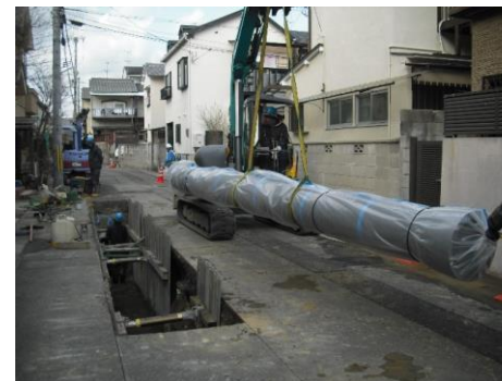
基幹管路更新工事（耐震管の設置）
