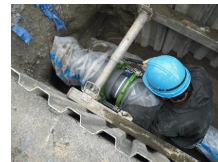
耐震管の接続
