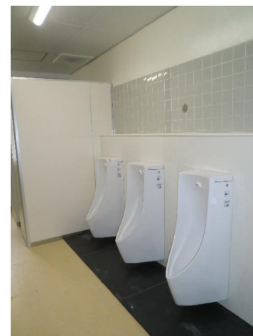
■トイレ改修後
