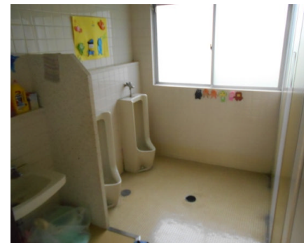
既存のトイレ施設
