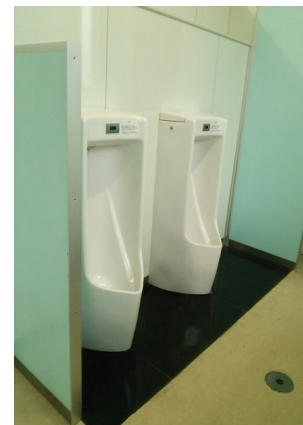
■第2向陽小学校（改修後）
