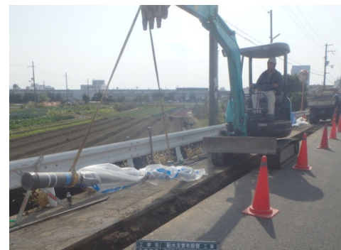
管路更新工事 (耐震管の設置)
