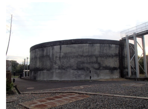
物集女第3配水池
