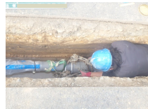
管路更新工事 (耐震管の接続)
