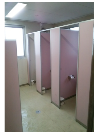
■第2向陽小学校（改修後）
