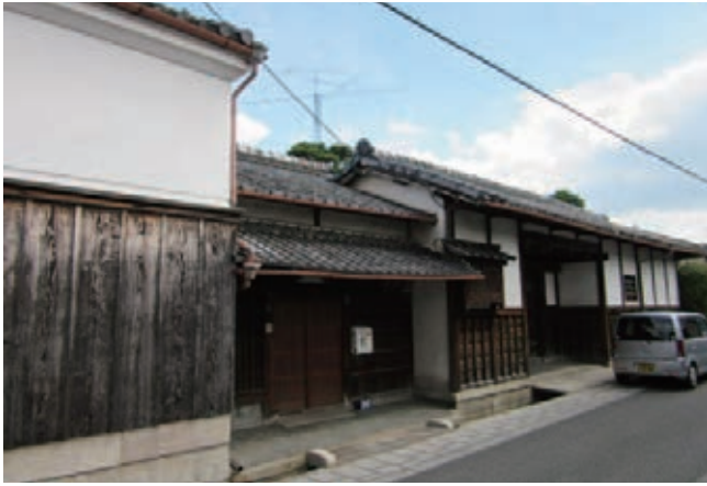
写真 1-4-5-3 西国街道沿いの商家（寺戸町）
