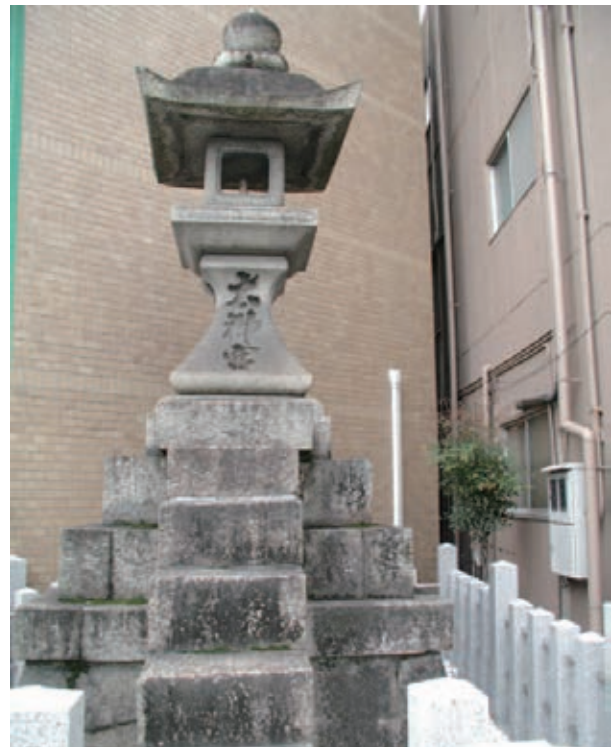
写真 1-3-1-17 西国街道に面し建つ常夜燈（計画認定時）
