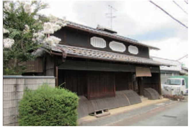
写真 1-4-5-4 西国街道沿いの町家風住宅（上植野町）
