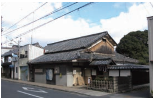
写真 2-3-3-5 富永屋店棟建物全景（南西から）
