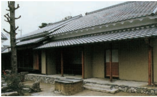
写真 2-3-3-3 須田家住宅裏庭からみた主屋西面
