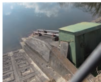
写真 2-4-3-3 寺戸・はりこ池の樋
