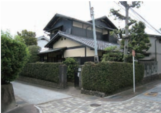
写真 2-6-2-7 向日庵（寿岳邸）北西からの外観
