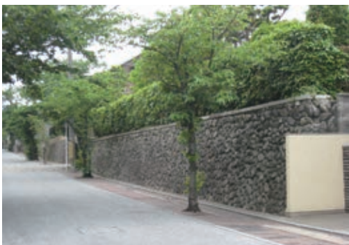
写真 2-6-2-11 藤井厚二設計の住宅があった敷地の石積み
