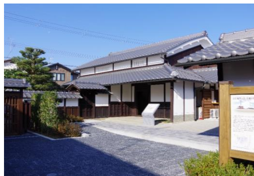
敷地内から主屋を望む
