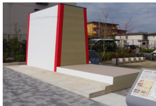
南内裏公園内に整備した 史跡長岡宮跡の内裏外郭築地
