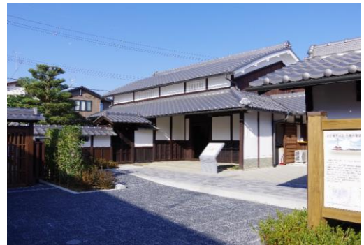
敷地内から主屋を望む
