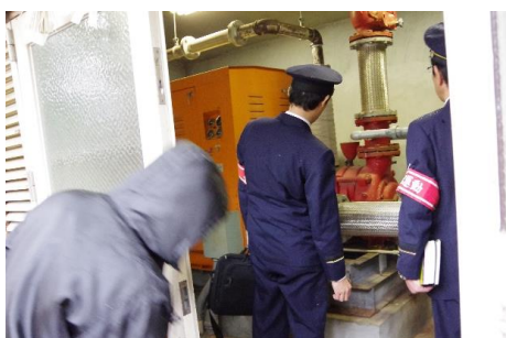
防火設備点検(向日神社)
