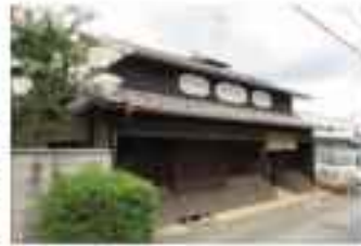
写真 1-4-3-4 西国街道沿いの建屋（神戸町）
