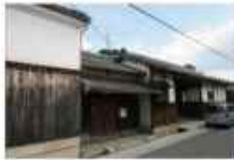
写真 1-4-3-3 西国街道沿いの建屋（神戸町）
