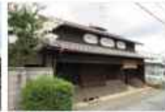
写真 1-4-4-4 西国街道沿いの建屋（神戸町）
