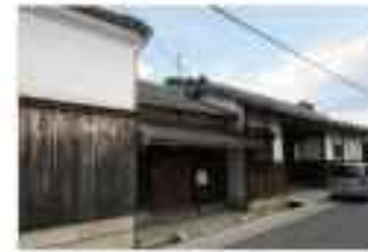
写真 1-4-4-3 西国街道沿いの建屋（神戸町）
