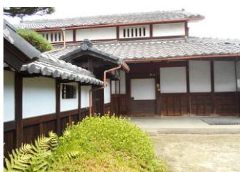
③旧上田家住宅 主屋玄関(南から)
