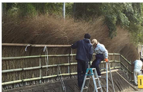
竹垣の改修の様子
