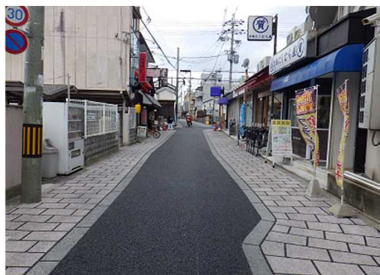
西国街道整備 (平成27年度整備箇所)
