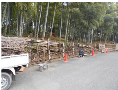
竹垣の改修の様子
