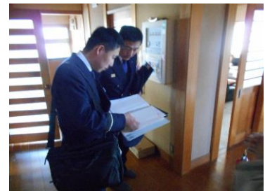
自動火災報知器点検
