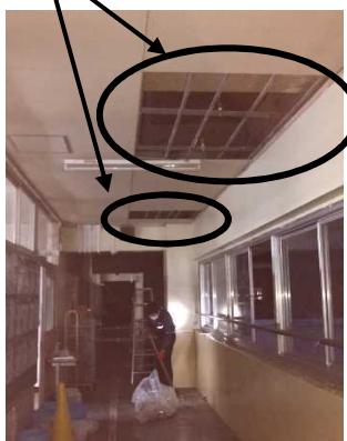
【ボード撤去後の状況】
