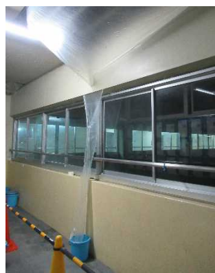
【応急漏水対策】
