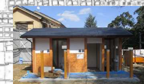
勝山公園トイレ改修
