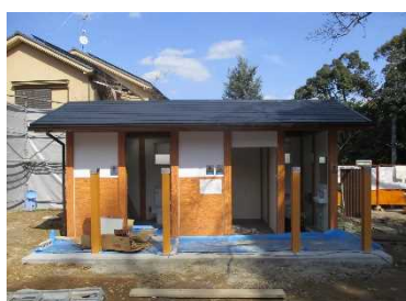
勝山公園トイレ改修
