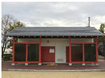
市民ふれあい公園トイレ改修
