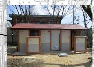
西向日公園トイレ改修
