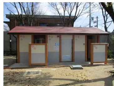
西向日公園トイレ改修
