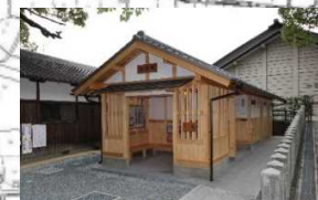
向日神社周辺 休憩所及びトイレ整備
