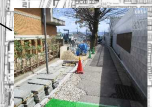
長岡宮跡周辺道路整備
