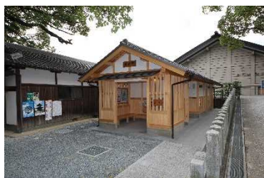
休憩所及びトイレ整備
