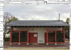
市民ふれあい公園トイレ改修
