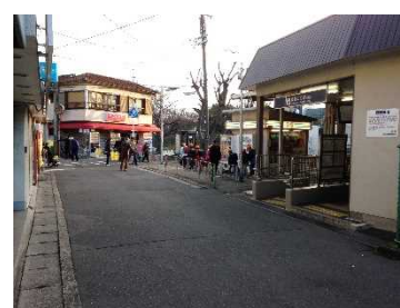
阪急西向日駅周辺道路整備
