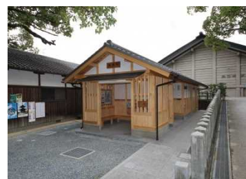
向日神社境内のトイレ 及び休憩施設
