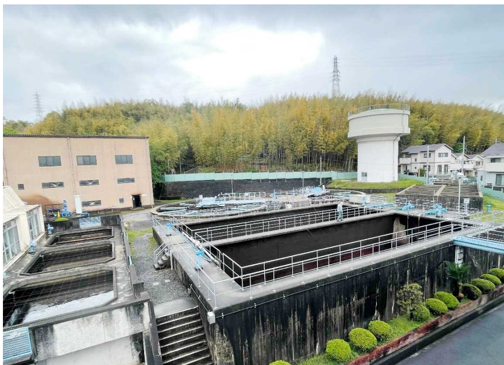
物集女西浄水場
