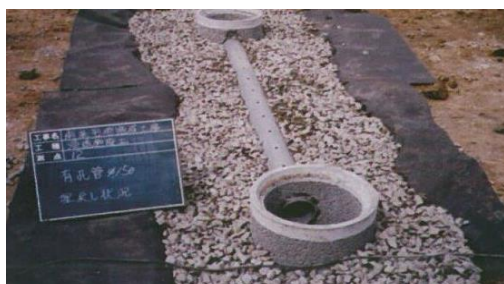
(雨水流出抑制施設設置例)
