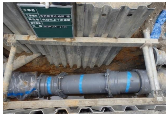
新たに布設した基幹管路
