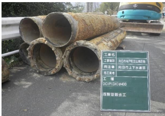
布設替に伴い撤去された既設管
