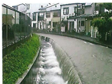
雨水流入施設（寺戸川〔永田〕流入口）
