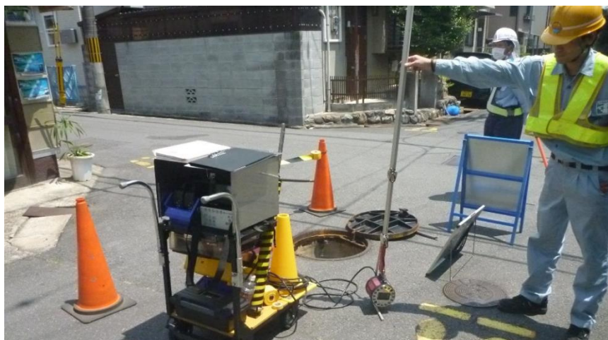
（写真1）管口テレビカメラ調査
