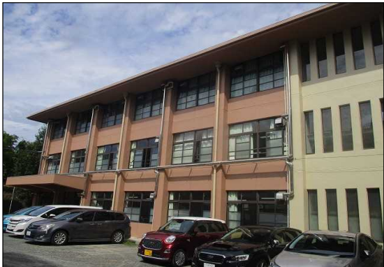
← 第6 向陽小学校 北校舎外壁塗装工事（完成）
