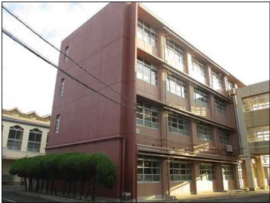
↑ 寺戸中学校 北校舎外壁塗装工事（完成）
