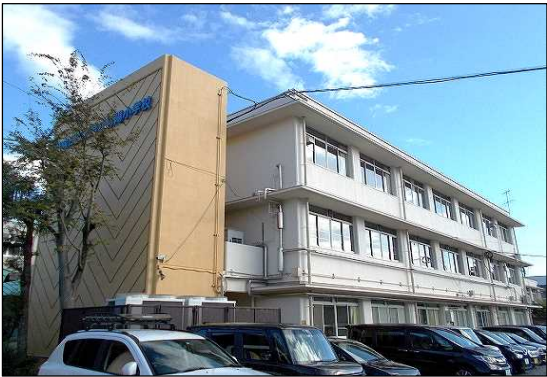
← 第4 向陽小学校 南校舎外壁塗装工事（完成）
