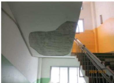
階段仕上げ軽量モルタル厚 10mm
