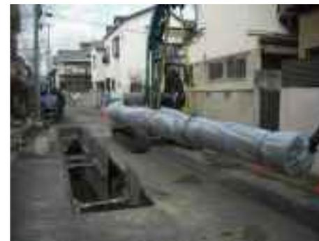
基幹管路更新工事（耐震管の設置）
