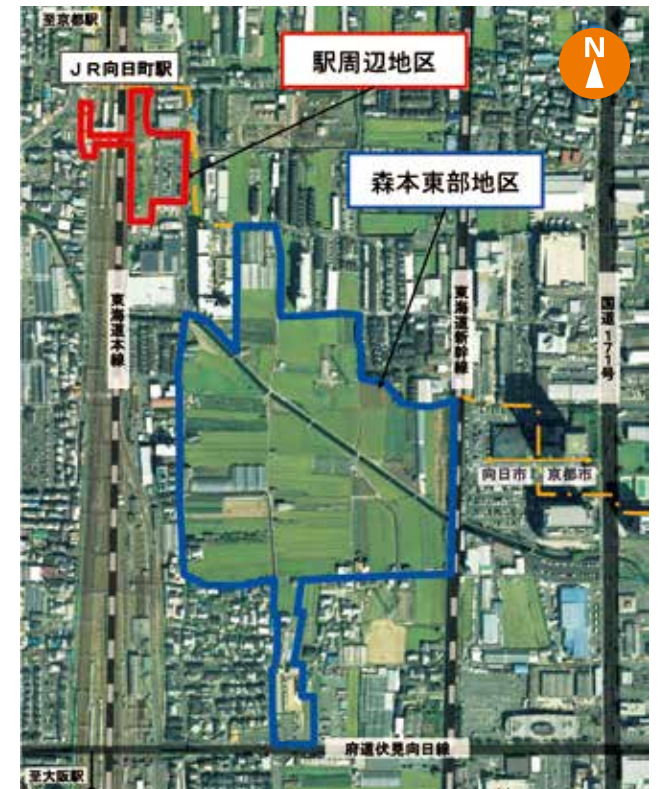
現況航空写真(着手前)
