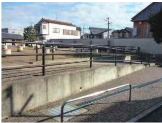
手すり(スチール)
