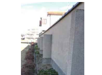
コンクリート擁壁
