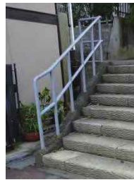
手すり(スチール)
