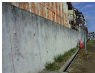
コンクリート擁壁
