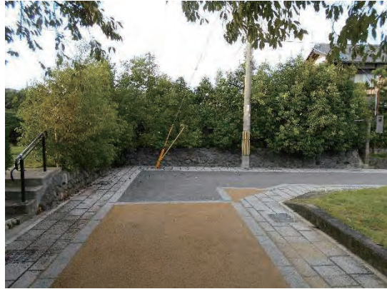
5-1 図 市道（史跡指定地）内に表示された長岡宮大極殿の遺構（美装化事業、道路の東西は史跡整備地、南から）
