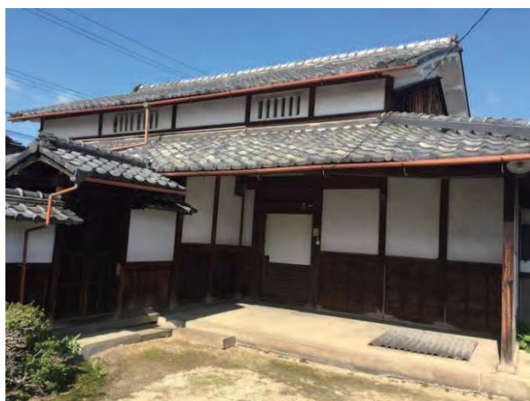
8-2 図 主屋（しゅおく、南東から）
