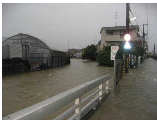
平成 25 年 台風 18 号 平成 25 年 9 月 14～16 日 (寺戸川付近の冠水 森本町)
