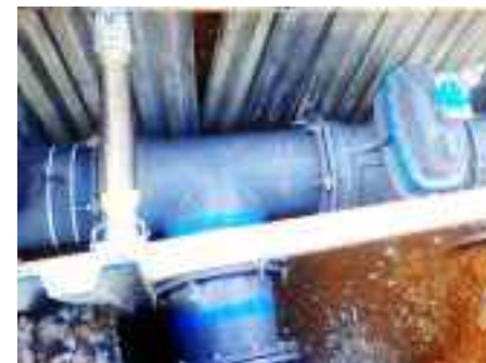
新たな耐震管の布設
