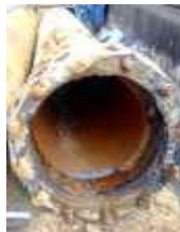
老朽化した水道管の撤去
