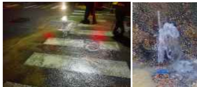
老朽配水管からの漏水
