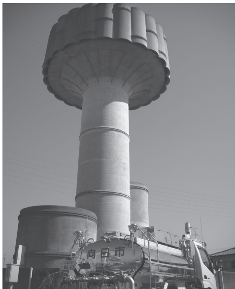
上植野配水塔と給水車
