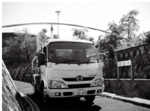
物集女配水池
