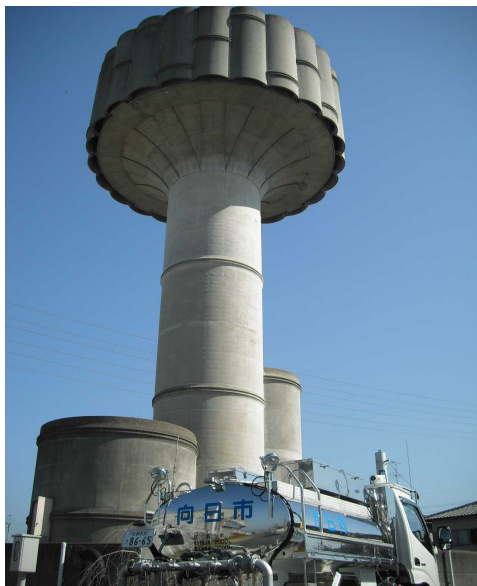
上植野配水塔と給水車
