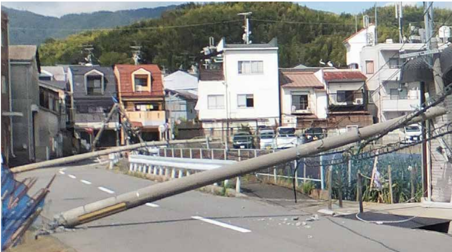
▲台風21号の暴風による電柱の倒壊 平成30年9月 物集女町
