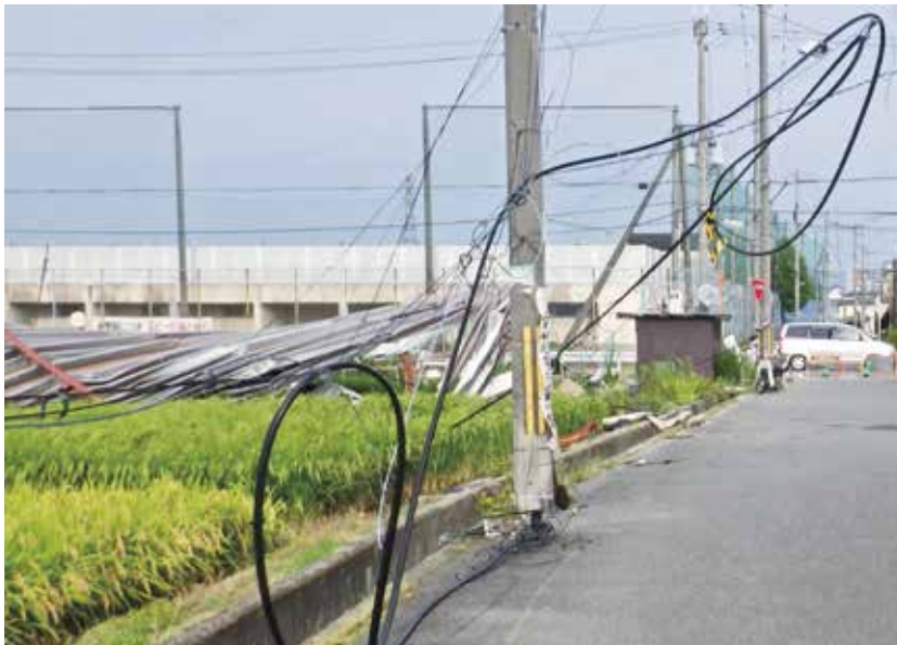
▲台風21号の暴風による鉄骨建物屋根の崩壊、電線の落下 平成30年9月 物集女町
