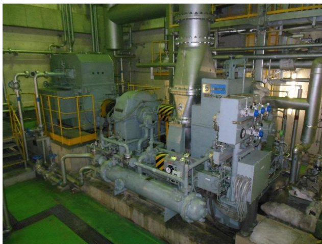
ごみ処理施設に設置されている発電機(蒸気タービン)
