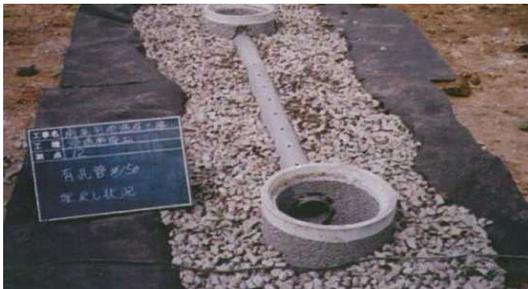
雨水流出抑制施設設置例
